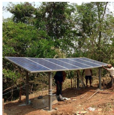
ติดตั้งโซลาร์เซลล์
